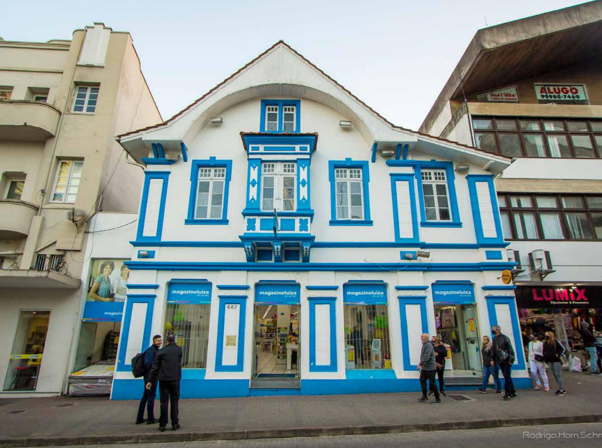
Com térreo, primeiro pavimento e sótão, sua fachada é simétrica, desconsiderando o anexo de dois pavimentos no lado direito e de um pavimento no lado esquerdo. Pilastras com quadros emoldurados marcam as extremidades do prédio e o corpo central no térreo. As aberturas do térreo são em verga reta com os cantos adoçados, tendo uma porta central e duas janelas, além de outra porta no anexo da direita.
