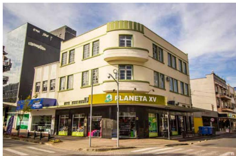
Frisos horizontais marcam as fachadas na altura dos peitoris, vergas das janelas e platibanda. Frisos menores em baixo relevo comparecem entre as aberturas e no guarda-corpo das sacadas. O piso térreo recebeu revestimento em granito preto e, na platibanda, na esquina, o friso horizontal é deslocado para cima e recebe elementos retangulares na vertical.
